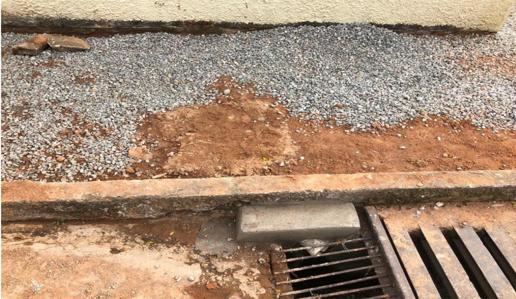
5 - Demolição de piso cimentado e construções de sarjetas para saída de águas pluviais.
